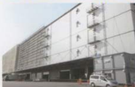
●外壁の改修に!
