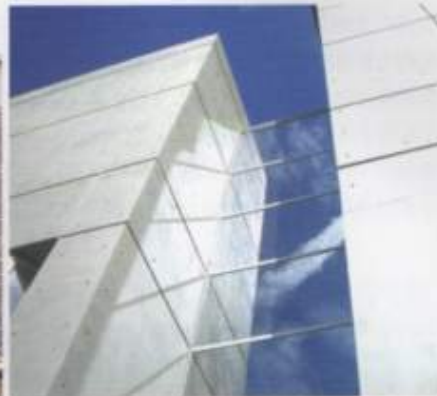
鹿島建設(株)技術研究所(東京都) 施工:2007年 外壁(RC面)
