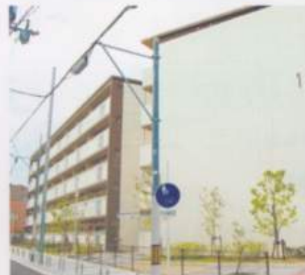
大阪府宮帝塚山住宅(大阪府) 施工:2007年 外壁(吹付塗装面)
