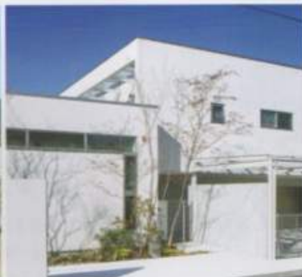
足利の家(栃木県) 施工:2007年 外壁(着色塗装面)
