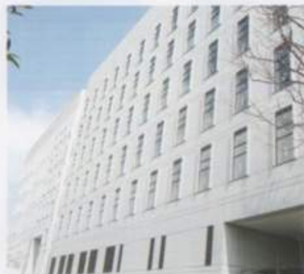
東京大学(駒場Ⅱ)総合研究実験棟(東京都) 施工:2011年 外壁(RC面)
