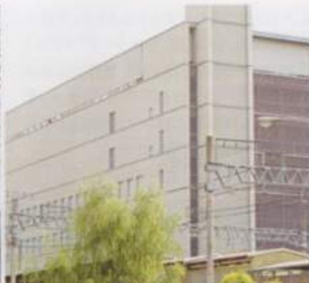
JR東海ビル(愛知県) 施工:2006年 外壁(石器タイル、RC面)ガラス、アルミサッシ
