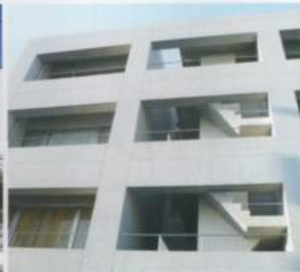
APT,新梅田改修工事(大阪府) 施工:2010年 外壁(RC面)
