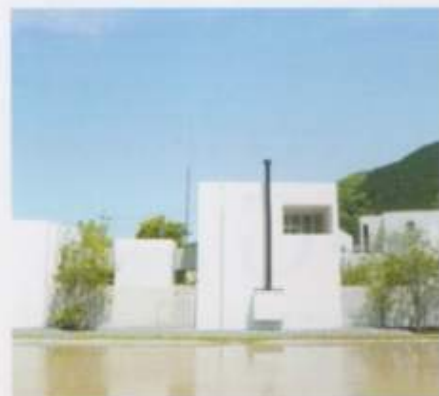
勝山の家(岡山県) 施工:2007年 外壁(着色塗装面)
