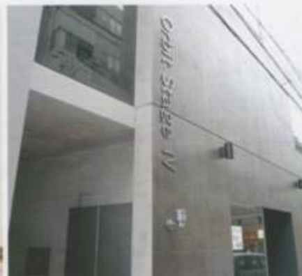
オービットステージⅣ(大阪府) 施工:2007年 外壁(打ち放し面に着色透かし仕上げ)
